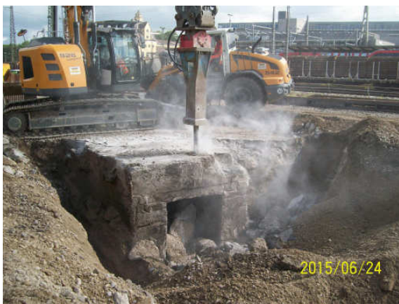
Abbildung 2: Rückbau des Bunkers, welcher sich als sehr widerstandsfähig erweist (Fotos Stadt Augsburg)
