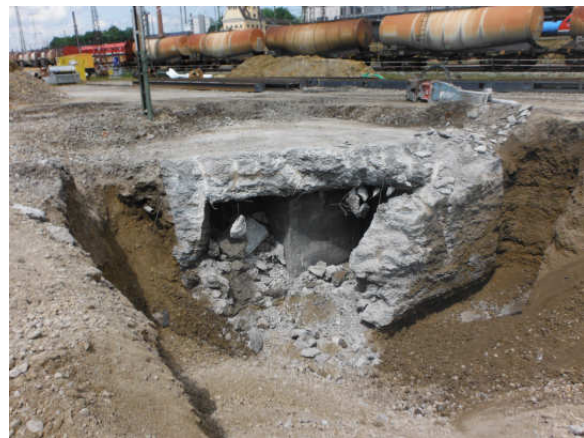
Abbildung 2: Rückbau des Bunkers, welcher sich als sehr widerstandsfähig erweist (Fotos Stadt Augsburg)
